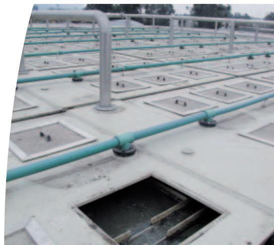
*Biorreactor de tipo UASB. Biogas en producción.*
