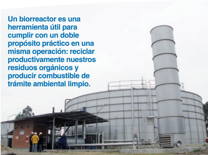
Biorreactor de tipo UASB.
