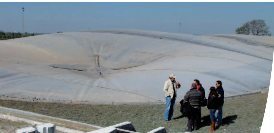
*Biorreactor de contacto o mezcla completa (laguna).*
