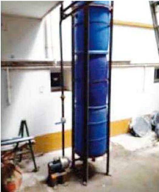
**Figura 53.** Torre de refrigeración para agua de enfriado del sistema de alimentación de biomasa al reactor.
