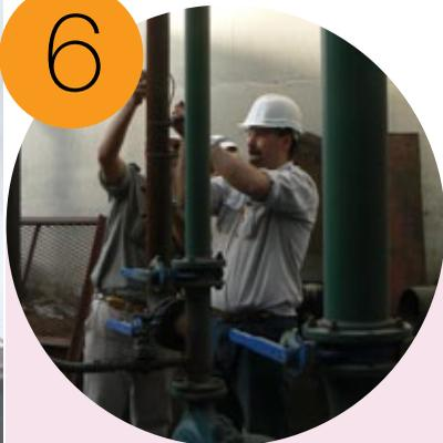
Caudal (Gag.scr.), presión (Pag.scr.), concentración de partículas (SSV), Ph y conductividad (CE) del agua a la entrada del lavador de gases (scrubber). Valores normales para calderas convencionales: Gag.scr.= 1,5 a 2,5 Gvapor; Par. = 2 a 3 [bar]; SST = 0 a 5 [ml/l]; Ph = 6 a 8 [u.pH] y CE = 0,2 a 5,0 [uS/cm].
