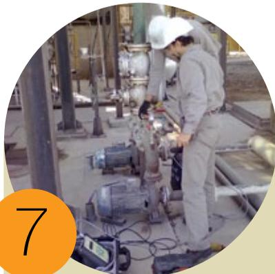
Concentración de partículas (SSV), Ph y conductividad (CE) del agua de salida del lavador de gases (scrubber). Valores normales para calderas convencionales: SST = 100 a 200 [ml/l]; Ph = 7 a 9 [u.pH] y CE = 0,8 a 11,0 [uS/cm].
