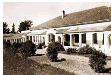
Vista posterior del nuevo edificio central de la EEAT en la década de 1940.
