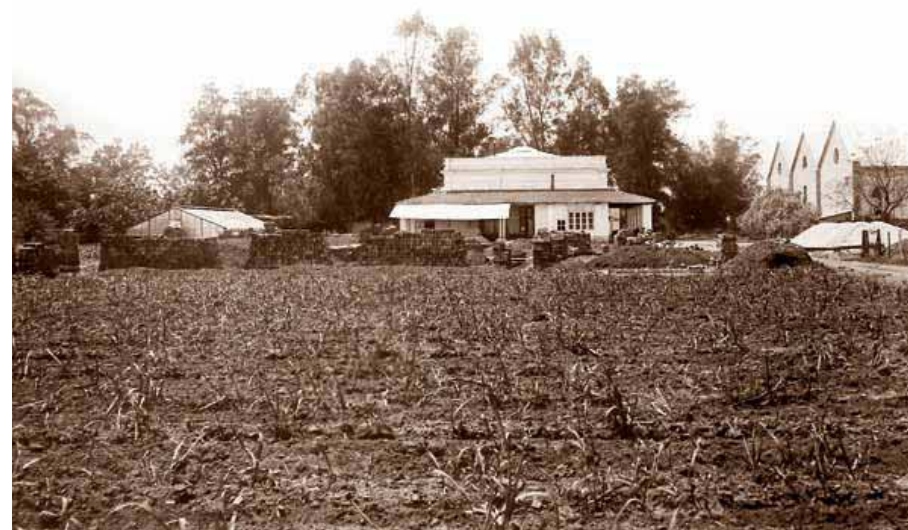
Construcción del nuevo edificio de la EEAT, 23 de octubre de 1927.
