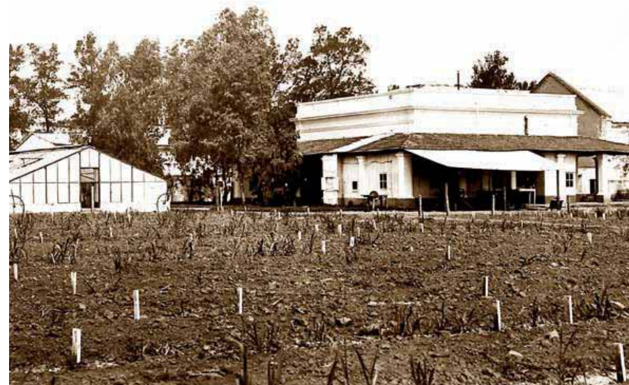
Instalaciones de la EEAT en El Colmenar, década de 1910.
