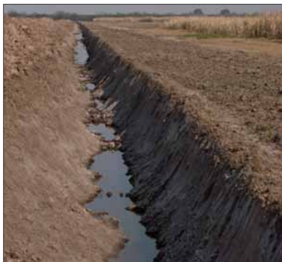
Figura 5: Canal de drenaje en la región de la Llanura Deprimida.
